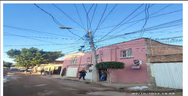
Los habitantes se conectan a un poste de energía eléctrica; el servicio no está regulado. Fuente: Archivo propio. Octubre, 2022
