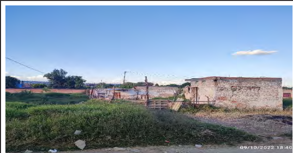
Vivienda habitada, sin servicios y en obra negra. Fuente: Archivo propio. Octubre, 2022
