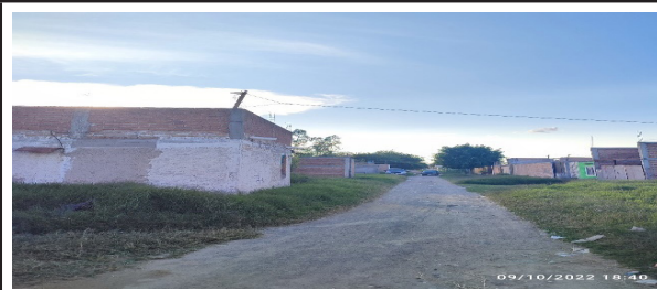
Se observa la falta de postes de electricidad, en consecuencia no hay alumbrado público. Fuente: Archivo propio. Octubre, 2022
