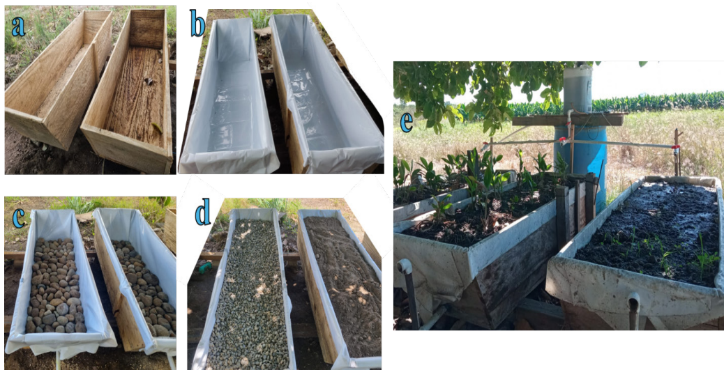
Figura 2. Etapas de la construcción de los HA: a) dos cajas de madera, b) membrana impermeable de polietileno, c) capa inferior de piedras de río, d) capa de grava y tierra, e) HA plantado con A. purpurata (a 60 días de operación)
